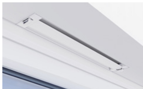
zewnątrzna strona okna
